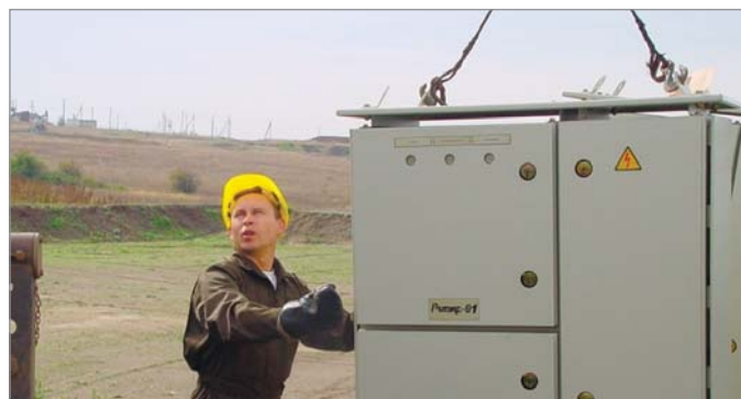
Монтаж станции управления «Ритэкс-01» на месторождении. Работы выполняет представитель сервисной службы ООО «РИТЭК-ИТЦ» Н.П. Гагарин. 2003 г.
